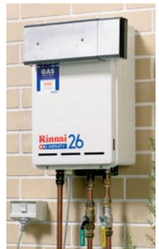
Flue Diverter
